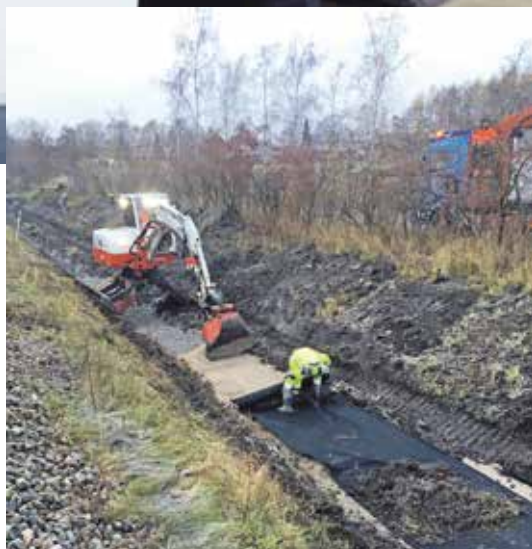
Bjælkehøjs lidt finurlige gravemaskine i sving med oprensning af en grøft langs et jernbanespor. Maskinen har udskydelig undervogn, den kan hæves, og larvebåndene kan tiltes, så der altid er solidt fodfæste også på skrånninger.
