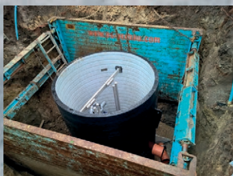
PE Flex Hybridbrønd Kombineret højvandslukke og pumpebrønd
