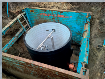
PE Flex Hybridbrønd Kombineret højtandslukke og pumpebrønd
