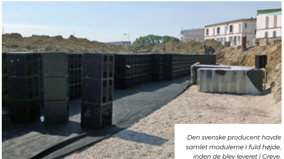
1044 kubikmeter regnvandskassetter godt på vej i Greve.
