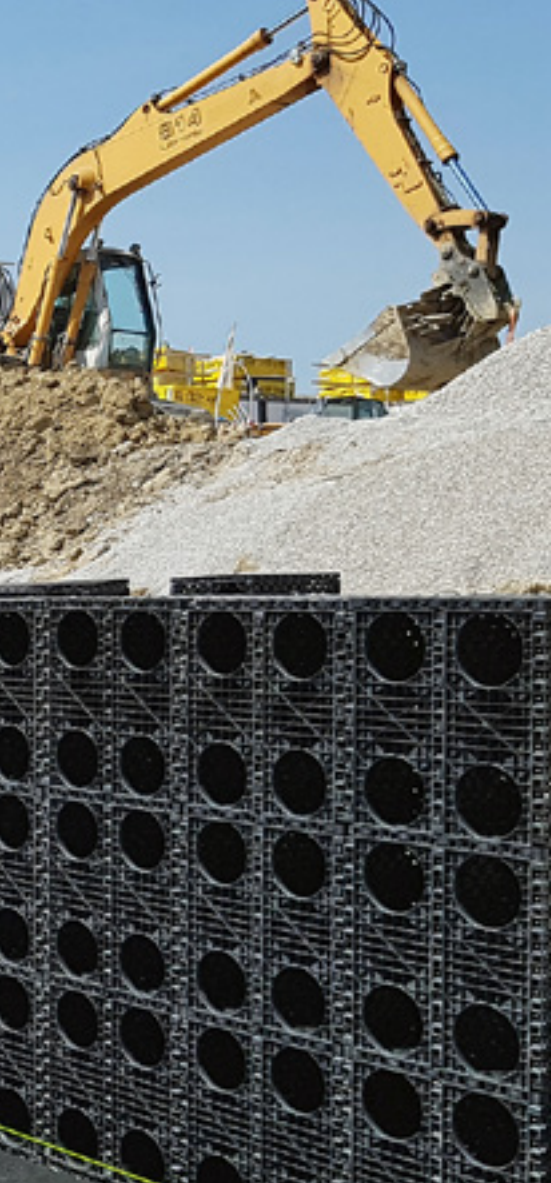
1044 kubikmeter regnvandskassetter godt på vej i Greve.
